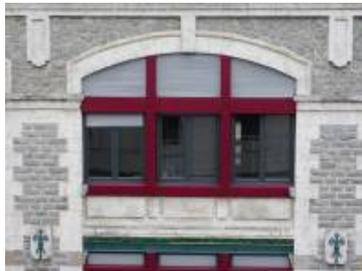
L' atelier subsistant est constitué de 3 étages. Le rez-de-chaussé et les travées centrales sont en pierre de taille en granit. Les baies des trois travées centrales s' inscrivent dans 3 encadrements harpés en pierre de taille en calcaire et trumeaux en pierre de taille en granite. Les baies des 2 travées latérales, entièrement en pierre de taille en calcaire, sont cantonnées de pilastres, et couronnées de 2 frontons.
